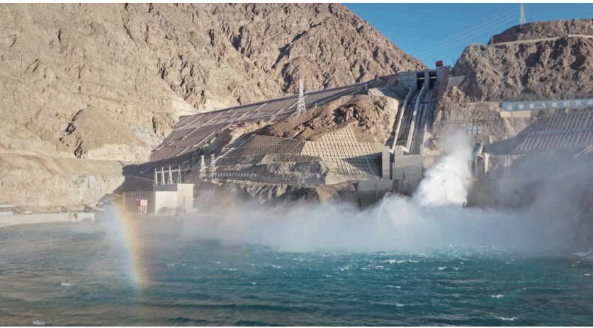
图为新疆大石峡水利枢纽(无人机照片,9月29日摄)。
