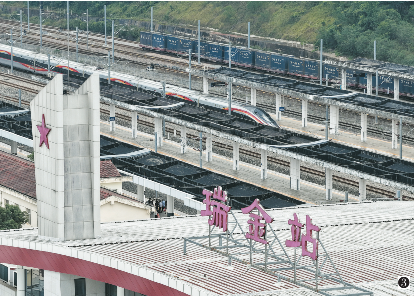
图①为9月6日，瑞金至延安高铁首发列车乘组人员在发车前留影。图②为9月6日，演员们在瑞金至延安高铁首发列车车厢内表演节目。图③为即将发车的瑞金至延安高铁首发列车(9月6日摄，无人机照片)。(新华社发)
