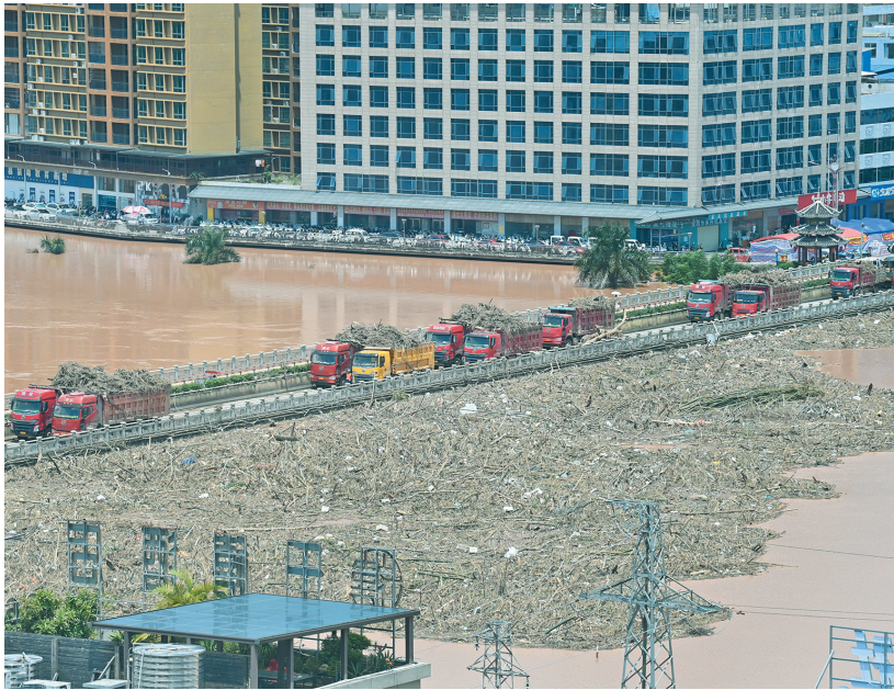
受今年第19号台风“紫檀”影响,广西崇左市宁明县明江水位暴涨,宁明大桥遭遇漫桥风险,当地启用10多辆重型卡车压桥护桥,迎战过境洪峰。这是8月25日拍摄的停放重型卡车的广西南明县宁明大桥。
