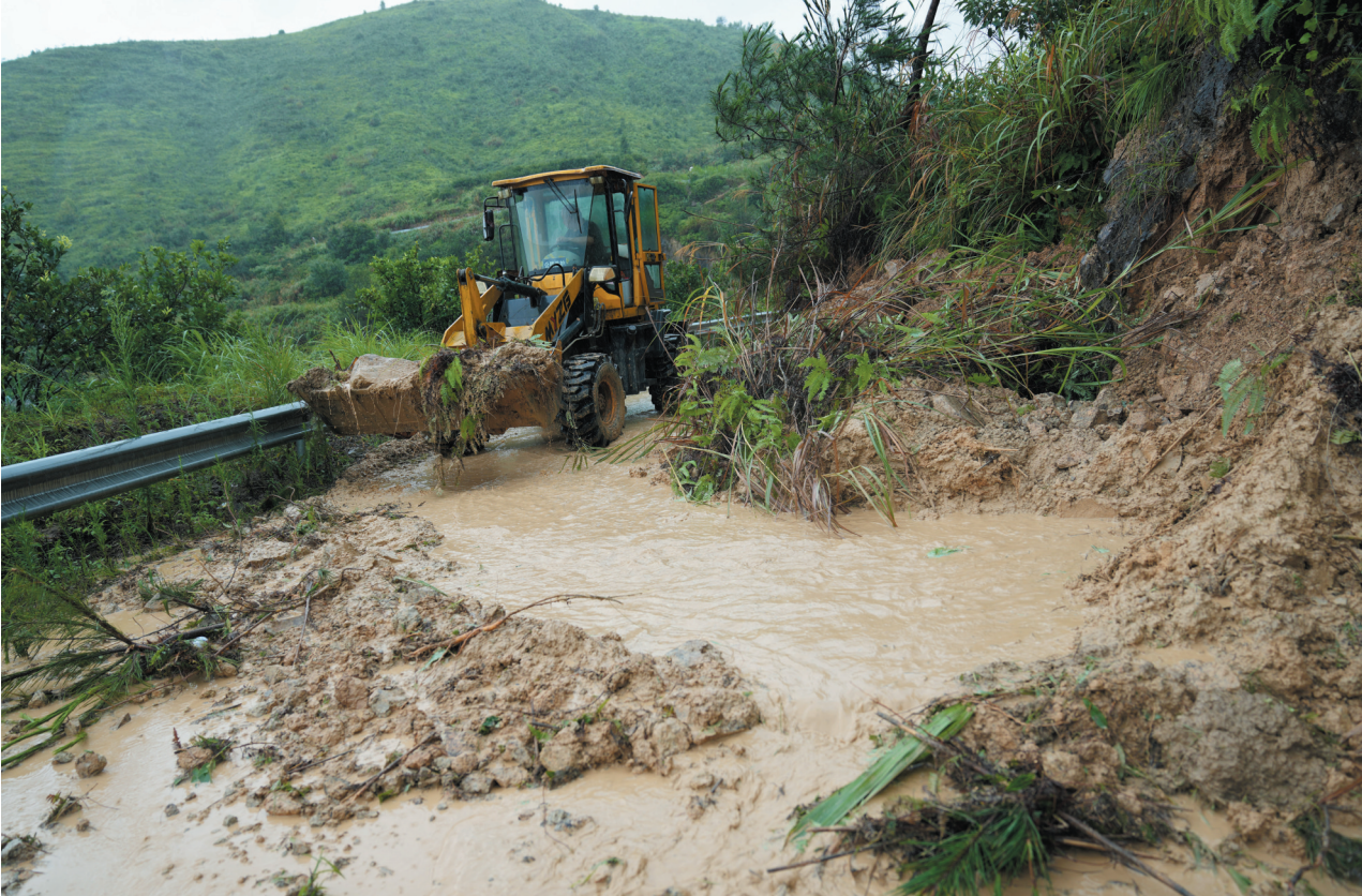
图为7月12日,在浙江省丽水市青田县季宅乡皇山村,工作人员操作挖掘机紧急清理被小规模山体滑坡阻断的县乡道路。(新华社发)
