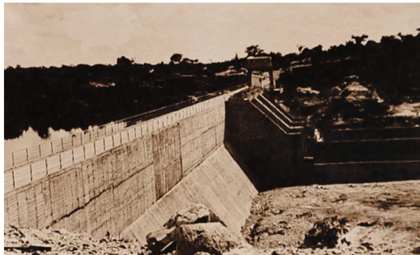
这是金康水电站大坝施工时的资料照片。
