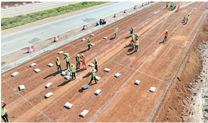
这是2025年10月3日在加纳首都阿克拉拍摄的由中铁五局加纳分公司承建的阿克拉-特马高速公路施工现场（无人机照片）。（新华社发）
