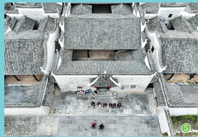
宝镜村位于湖南省永州市江华瑶族自治县群山之中,为清顺治七年(1650年)何氏先祖何应棋所建,因此又称“何家大院”,现存古民居180栋,7个门楼、36条巷道,是南方民居建筑和少数民族聚居区聚落空间适应性融合与演变的宝贵实物资料,其中走马吊楼(又称“长工楼”)是湖南省已发现体量最大的杂屋类建筑,极具研究价值。2016年宝镜村列入第四批中国传统村落,何家大院古民居于2019年被公布为第八批全国重点文物保护单位。何家大院的部分古民居目前正在修缮,这处藏于瑶山深处的传统建筑艺术与文化的“瑰宝”穿过历史的尘烟,迎来更加美好的明天。 图①为5月9日拍摄的宝镜古民居(无人机照片)。 图②为5月10日拍摄的宝镜古民居。 图③为5月10日,一名村民在宝镜古民居前的小溪中洗衣服。 图④为5月9日拍摄的宝镜古民居外景(无人机照片)。 图⑤为5月10日,瑶族长鼓舞艺人在宝镜古民居里表演(无人机照片)。(新华社发)
