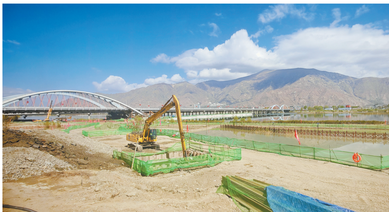
图为柳梧大桥B匝道建设项目现场。
