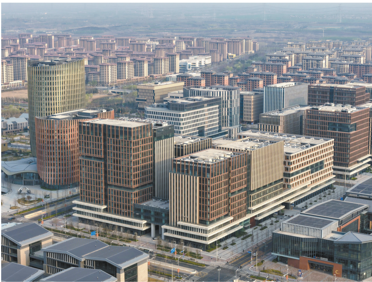
图为3月29日雄安新区局部一景(3月28日摄,无人机照片)。
