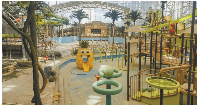
图为拉萨鸣升水世界项目建设现场。 拉萨融媒记者 杨璐摄
