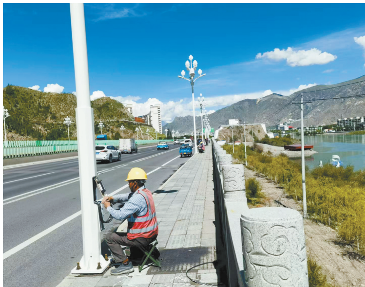
图为在南环路施工现场，施工人员进行接线调试。拉萨融媒记者 杨璐摄
