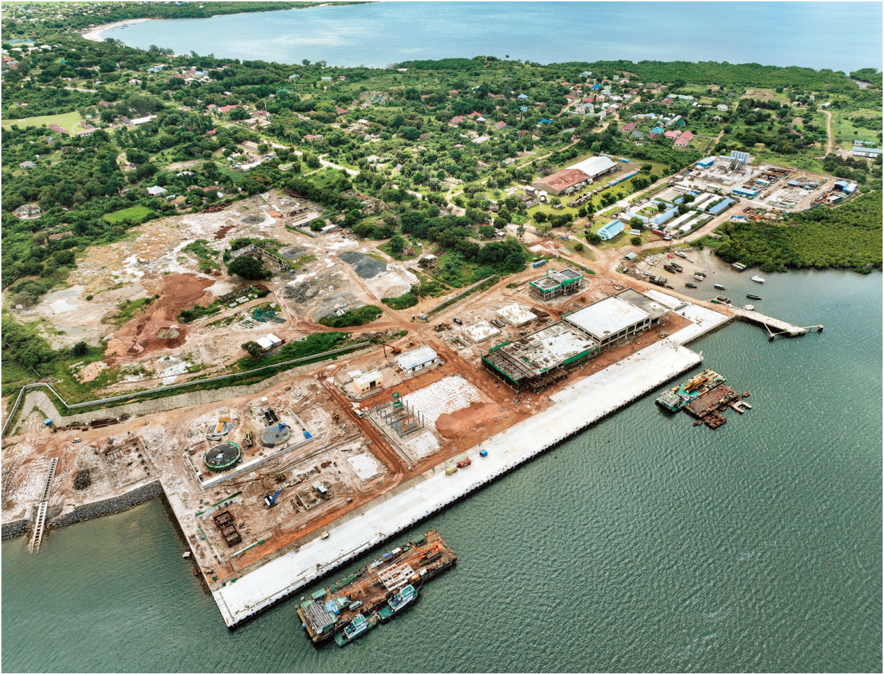
这是4月23日在坦桑尼亚东南部拍摄的基卢瓦渔港建设工地（无人机照片）。
