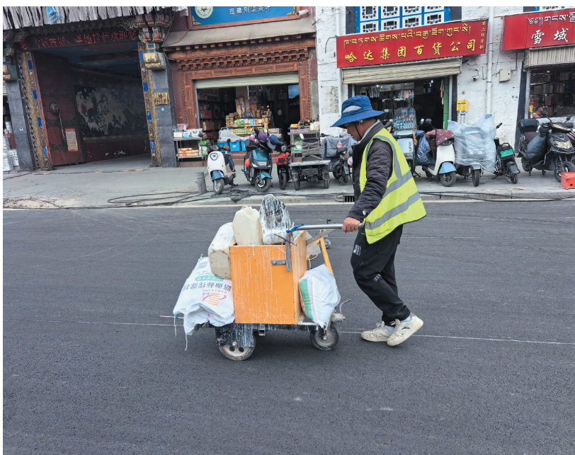
图为工人正在进行道路划线工作。 拉萨融媒记者 格桑卓嘎摄
