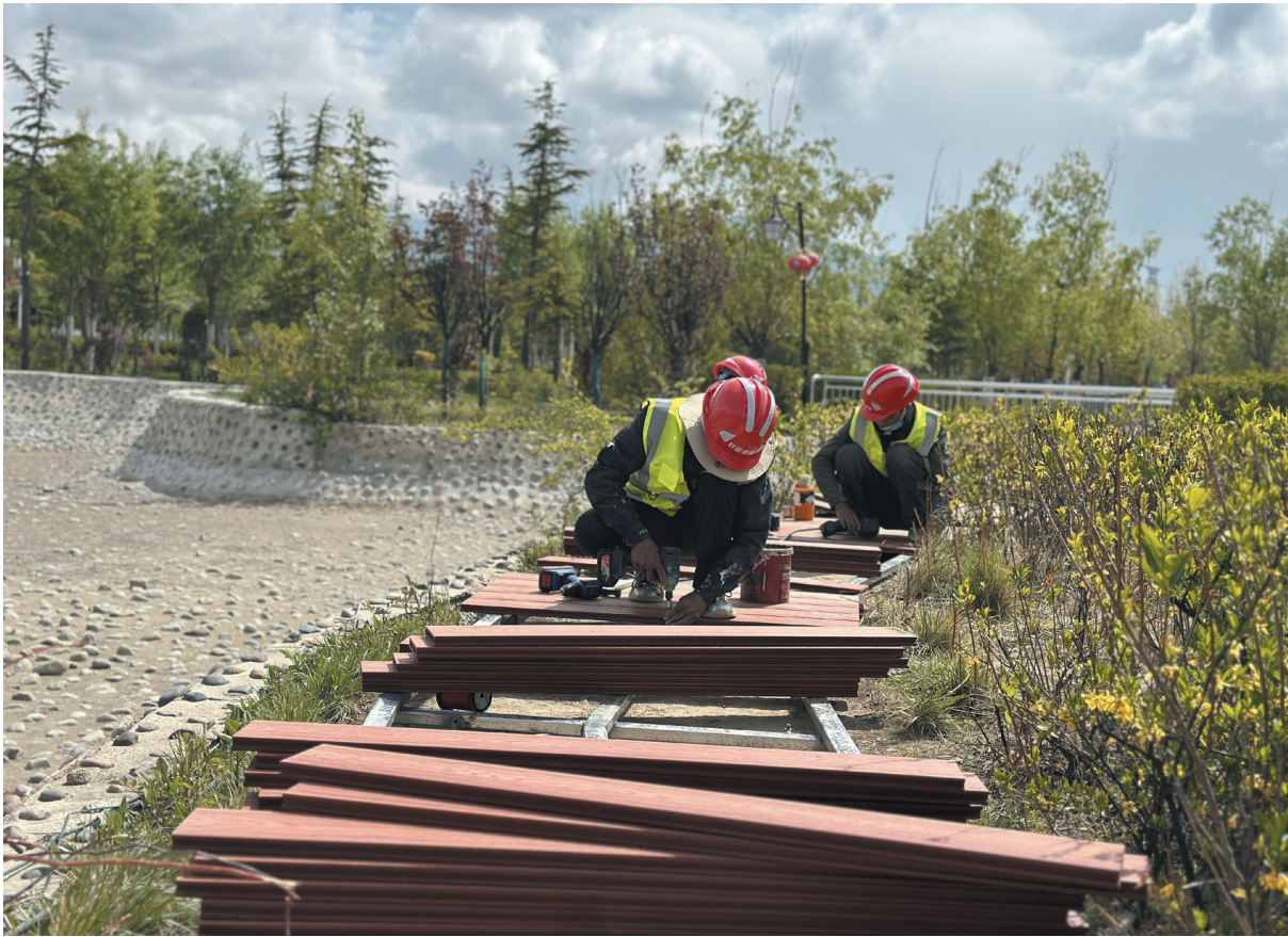
图为工人们在滨河公园内进行木栈道改造。
