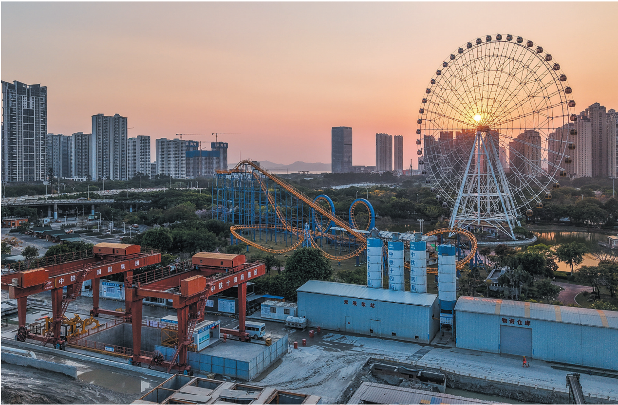
图为位于汕头湾北端的汕汕高铁汕头湾海底隧道施工现场（3月25日摄）。
