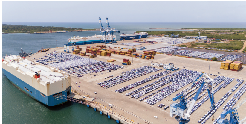
这是2024年7月29日在斯里兰卡汉班托塔综合开发项目拍摄的滚装业务。
