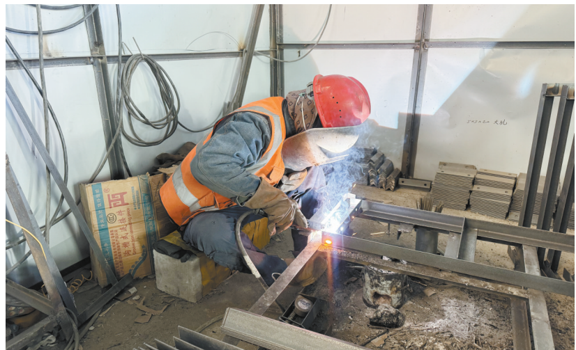
图为项目施工现场。 拉萨融媒记者 拉巴多吉摄
