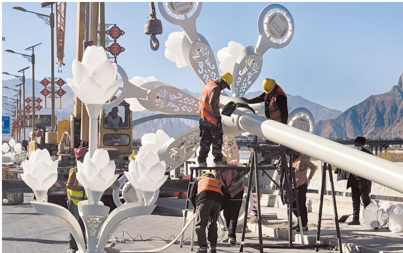
图为施工人员正紧锣密鼓地组装路灯。
