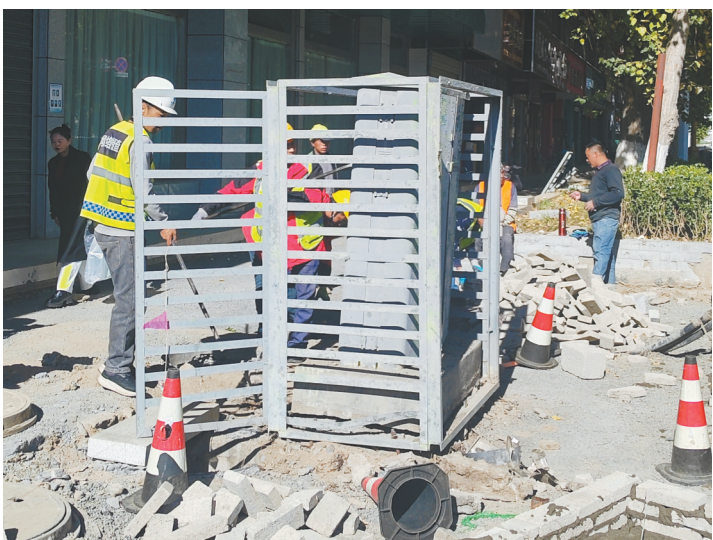
图为工作人员拆除罗布林卡路路边的箱体。 拉萨融媒记者 郝奕凝 摄
